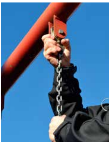
Kättingfästen i gungställning kollas för slitage.
